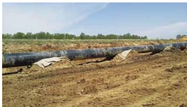
SKVパイプライン(サハリーン・ハバロフスク・ウラジオストック間幹線)に採用された高変形能鋼管
