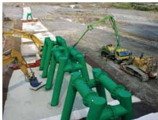
鋼製スリットダムB型
