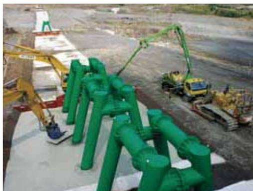
鋼製スリットダムB型
