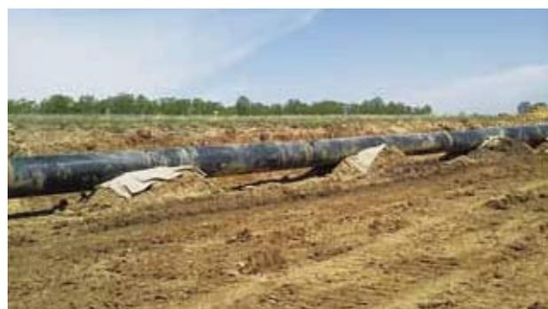
SKVパイプライン(サハリン-ハバロフスク-ウラジオストック間幹線)に採用された高変形能鋼管
