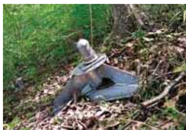
ノンフレーム工法の山林斜面施工例
