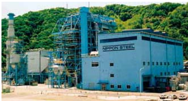
釜石製鉄所 電力工場
