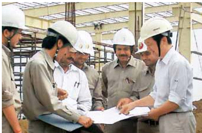
インド NPI の工場建設現場で工事の進捗を確認
