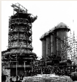
1900年建設中の官営八幡製鉄所第一高炉
