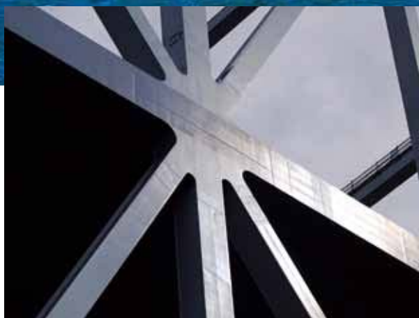
BHS 鋼を採用したトラス部
