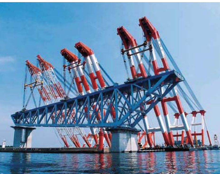
架設されるトラス部材（重量約6,000トン、若洲側）
