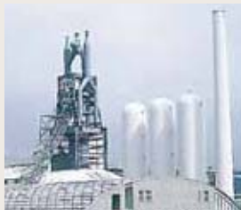
東田第一高炉跡の現在の様子 (北九州市の指定史跡として保存整備されている)
