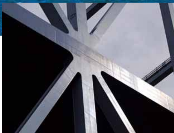
BHS 鋼を採用したトラス部
