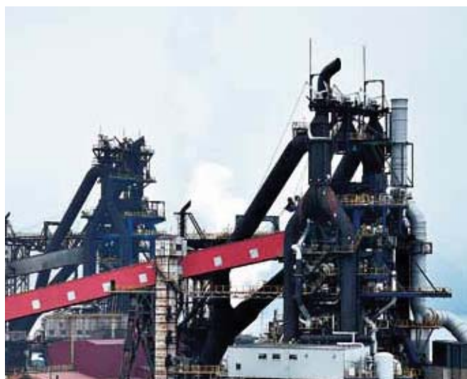
大分製鉄所第1・第2高炉（1基の容積 5,775m 3 ）
