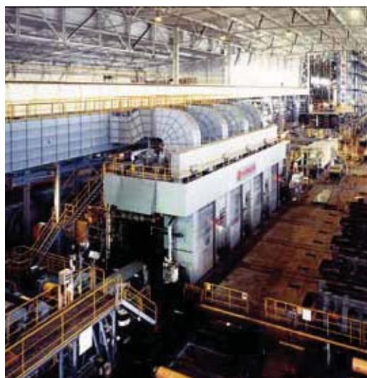
広畑製鉄所 完全連続冷延鋼板製造ライン
