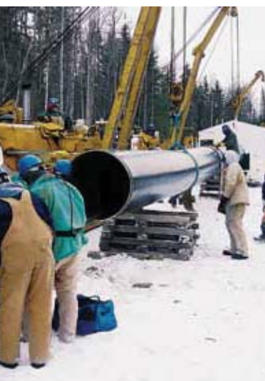
最高強度ラインパイプ「X120」の敷設風景
