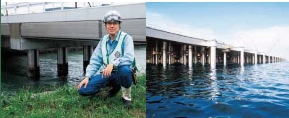
君津製鉄所第二東大橋(左)に試適用された新建材製品が、2010年にオープンした羽田空港D滑走路のジャケットに採用された(右)
