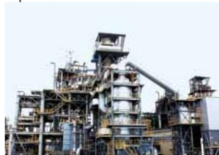
広畑製鉄所の製鉄ダストリサイクルプラント
