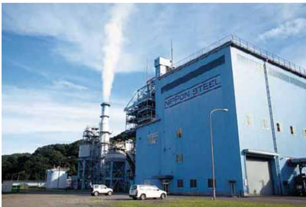
7月1日の運転再開と同時に煙突から水蒸気を排出したIPP設備。市民を勇気づける地域振興のシンボルにもなっている。
