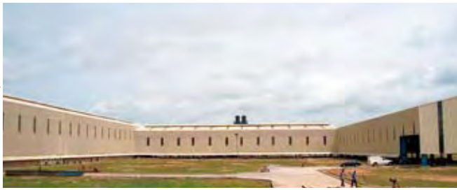
Midland Rolling Mills 全全景
