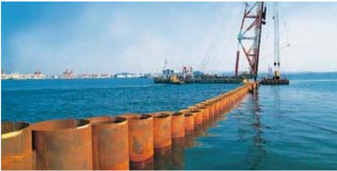
鋼管杭・鋼管矢板施工例 (港湾整備)
