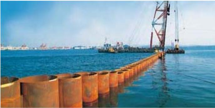
鋼管杭・鋼管矢板施工例 (港湾整備)
