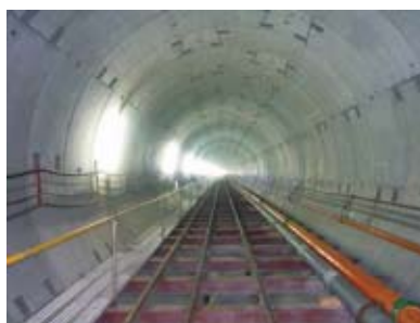
北島調節池築造工事(大阪府)
