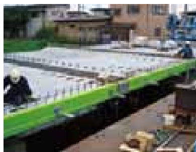
猿田川端橋での角太橋施工状況(秋田県秋田市)
