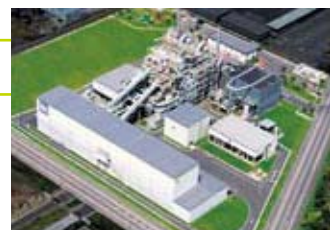
北九州エコエナジー(株) 全景
