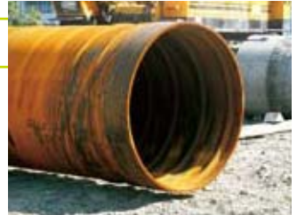
杭径φ1,400の鋼管杭(国内初採用)
