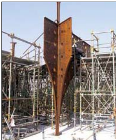
多摩美術大学図書館内部の鉄の構造体 (建設中) と完成後のフロア (右) (完成後写真 © 石黒写真研究所)
