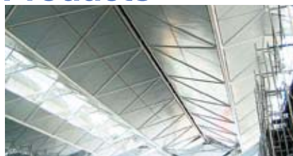
中部国際空港旅客ターミナルビル天井パネル
