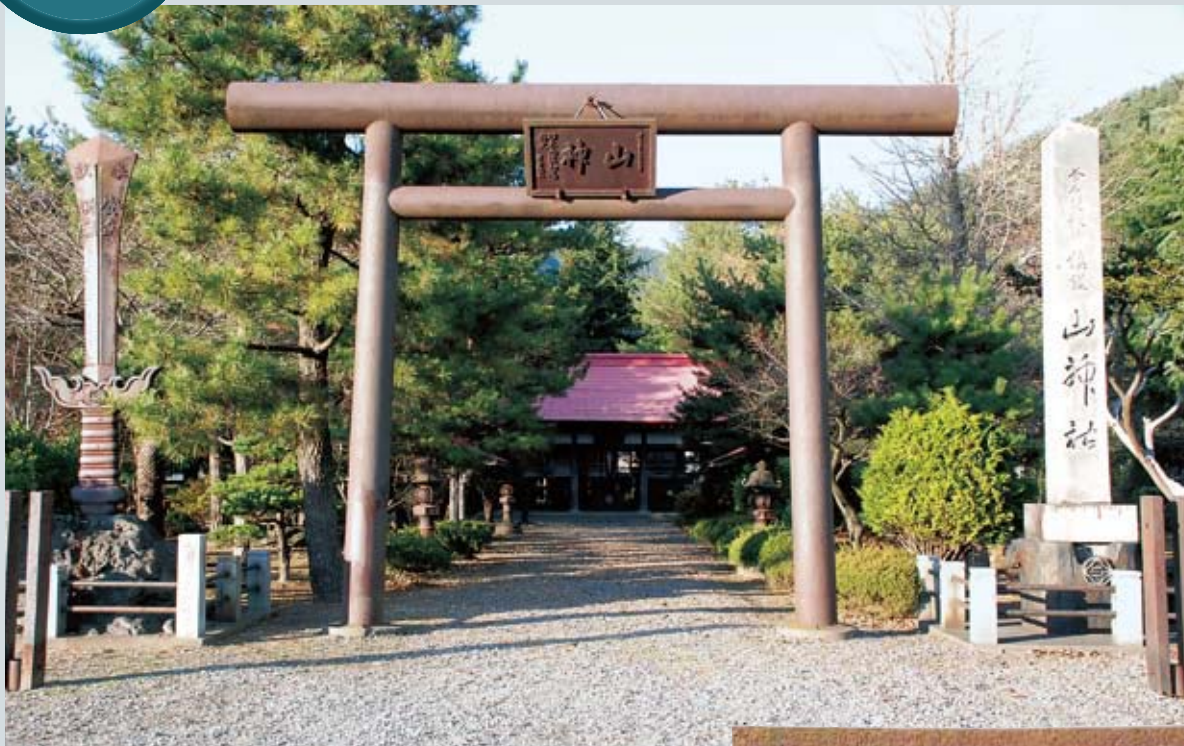
鳥居には富士製鉄時代に製造されたコルテン鋼が使用されている(昭和40年完成)
