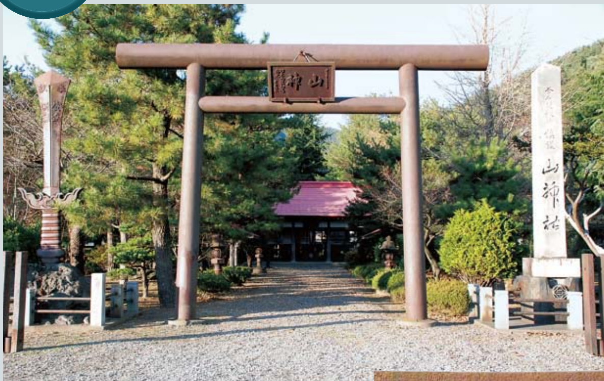
鳥居には富士製鉄時代に製造されたコルテン銅が使用されている(昭和40年完成)
