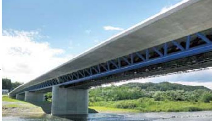
SBHS が採用された永田橋
