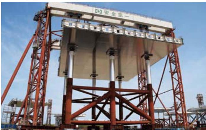
写真6 ジャケットの据え付け工事
