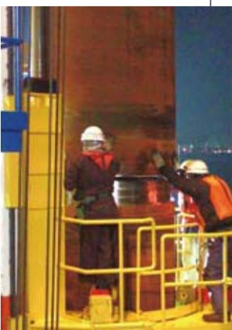
写真2 ラクニカンジョイントの接合作業
