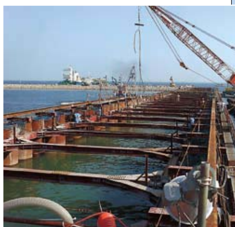
写真1 打設が完了した接続部の鋼管矢板群 (左側：埋立部、右側：栈橋部)
