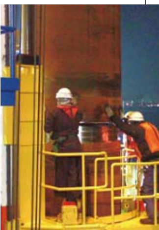
写真2 ラクニカン ジョイントの接合作業
