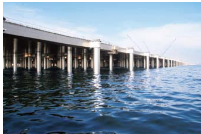
写真7 栈橋側面からのジャケット俯瞰
