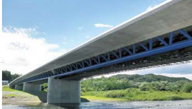
SBHS が採用された永田橋
