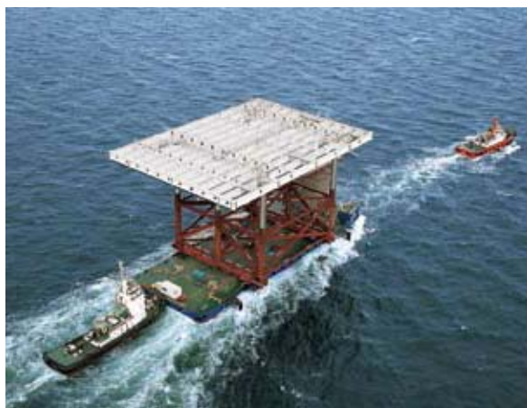
写真5 富津工場から羽田現場へ運ばれる完成ジャケット
