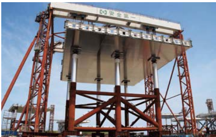
写真4 富津工場での搭載架構(吊上能力1,680トン)によるジャケット上下部一体化
