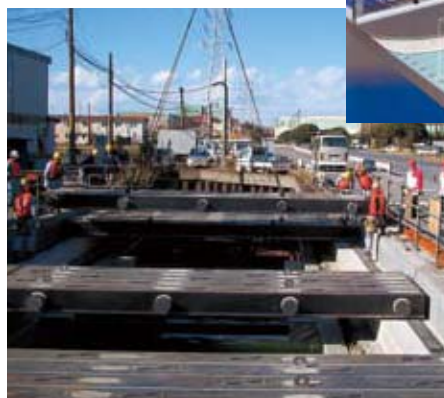
角太橋 ® の架設状況
