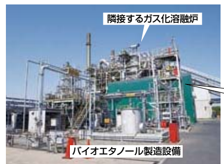
写真1 実証設備全景
