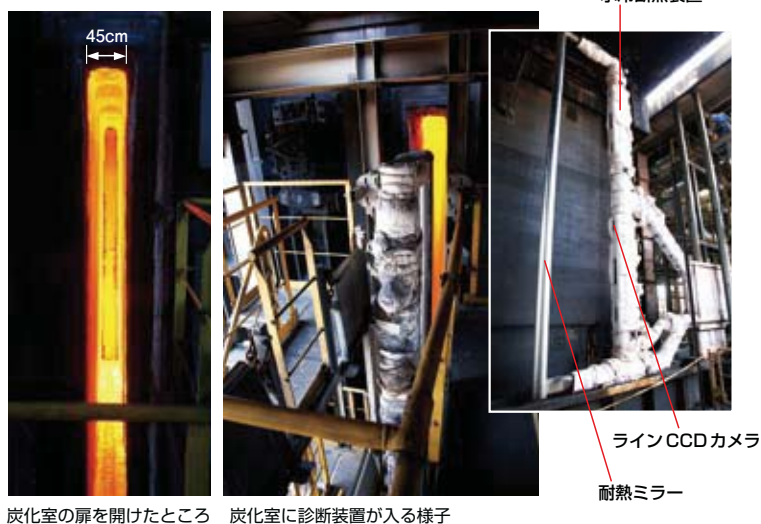
写真2 診断装置の炭化室への挿入
