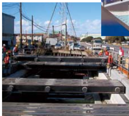
角太橋®の架設状況
