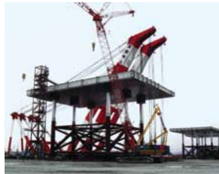
新滑走路棧橋部製作現場
