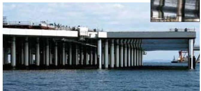
チタンカバープレートが採用された新滑走路棧橋部
