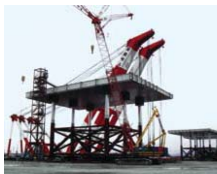
新滑走路栈橋部製作現場
