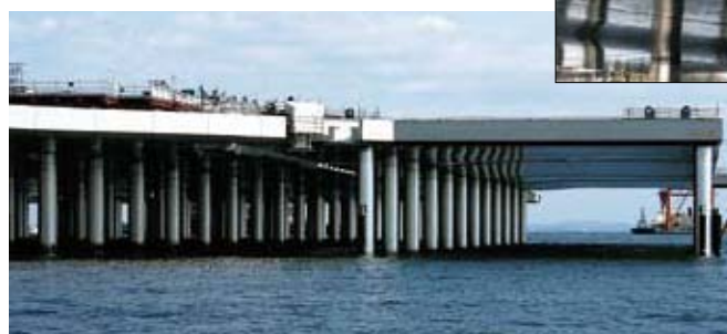
チタンカバープレートが採用された新滑走路栈橋部
