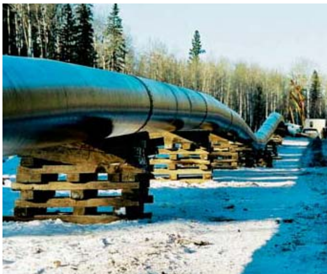
現地での円周溶接が終わった直後。その後、溝に降下され埋設される。
