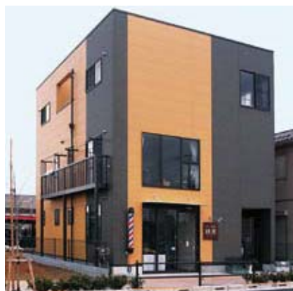
林建設が手がけた店舗併用住宅(東京都府中市 2009年2月竣工)
