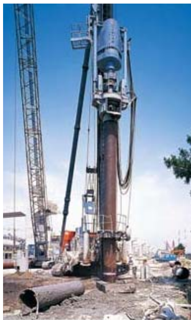
スパイラル鋼管の施工例 写真1
