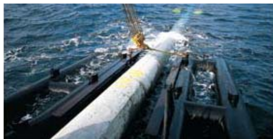
UO鋼管(ラインパイプ)の施工例 写真3
