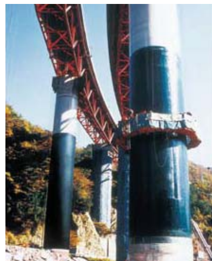
写真2 トウシート工法適用事例
