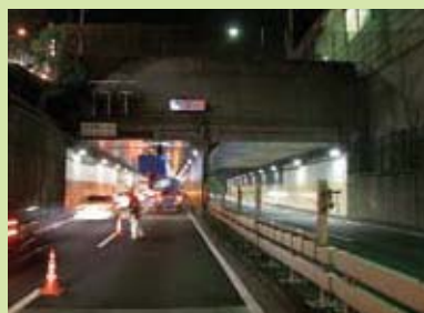
首都高速4号新宿線信濃町トンネル 施工現場 一車線を規制し作業を実施
