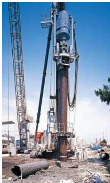
電縫鋼管(油井管)の施工例 写真2
