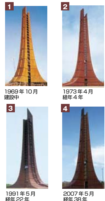
写真5 コルテンが使われている「北海道百年記念塔」外観の経年変化
