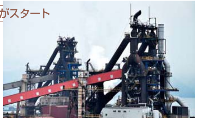
大分製鉄所の世界最大ツイン高炉(右が第1高炉、左が第2高炉)
