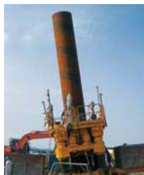
NSエコパイル ® 斜杭施工状況
