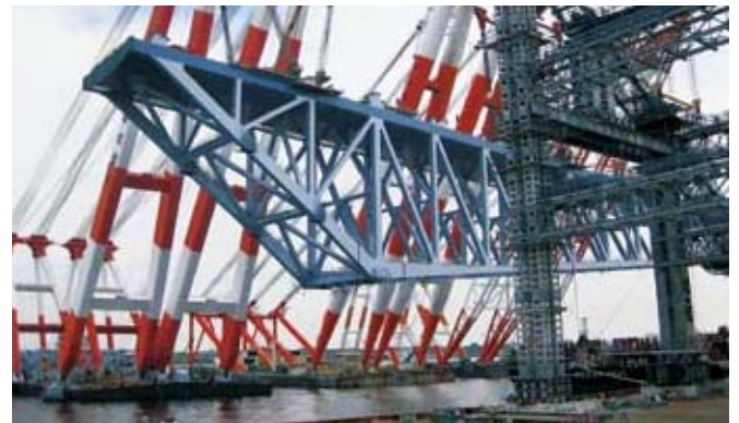
東京港臨海大橋（仮称）トラス橋梁浜出し状況
