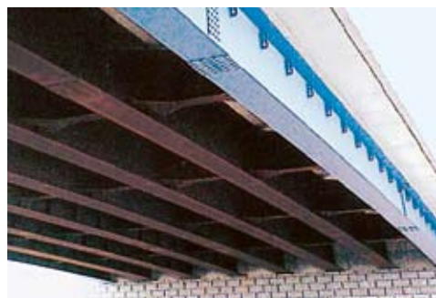
無塗装 Ni 系高耐候性鋼橋 (外桁には景観性を考慮した N 処理を適用)
