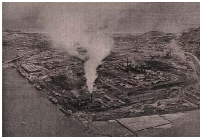
1960(昭和35)年ころ 第3次拡張工事が進む製鉄所全景（新航空写真(株)）
