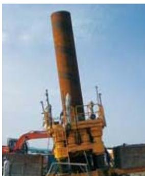
NSエコパイル<sup>®</sup> 斜杭施工状況
