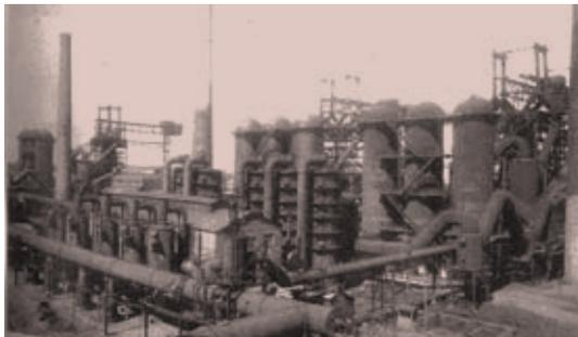
日本製鉄株は1937(昭和12)年4月、銑鋼一貫製鉄所を建設するため、仲町工場建設に着手。新たに231万㎡の海を埋め立てた。第1高炉は1939(昭和14)年12月に火入れされ、第2・第3高炉は1941(昭和16)年8月までに建設された。
