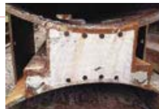
モルタル充填後の「Super Junction」の断面
