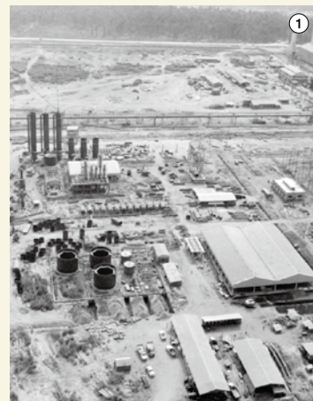
写真① 製鉄所の建設風景(1960年)
