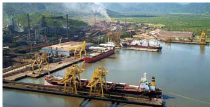
港湾設備では原料(石炭)の揚陸やスラブの輸出が行われている
