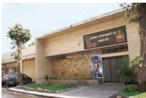
製鋼サブセンター入口
