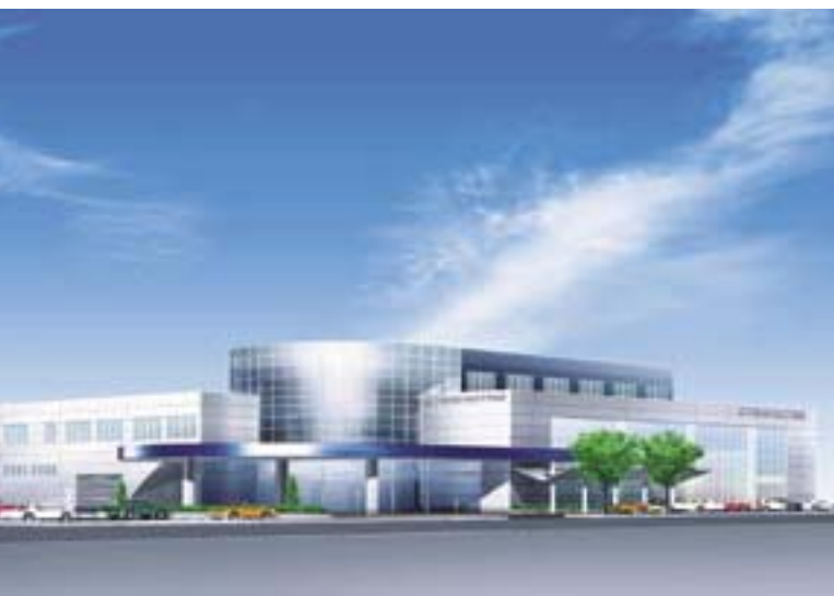
建設中のサイバーダイン社 研究開発・生産施設 (完成予想図)
