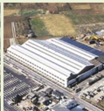
工場物件一改修後
