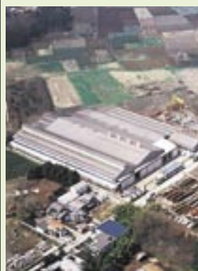
工場物件一改修前
