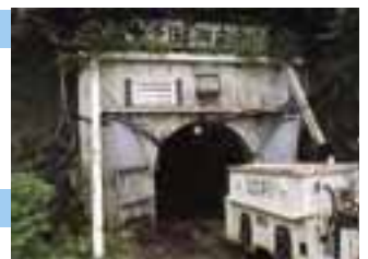
釜石鉱山坑口
