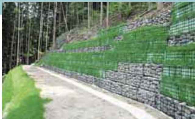
カゴ枠使用土木工事の例
