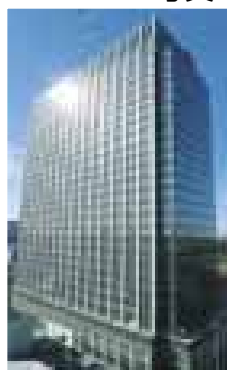
明治安田生命ビル
