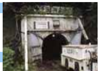
釜石鉱山坑口
