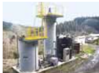
実証プラント
