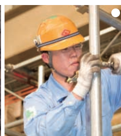
足場架設 鋼管・直交クランプ・足場板・番線を使用し、安全で堅固な足場を架設する。
