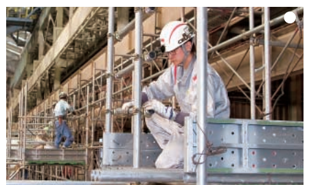
足場架設 鋼管・直交クランプ・足場板・番線を使用し、安全で堅固な足場を架設する。
