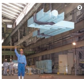
② 玉掛け 補助員に的確な指示をしながら安全でバランスのとれた玉掛けを行う。
