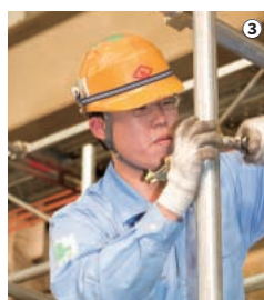
③ 足場架設 鋼管・直交クランプ・足場板・番線を使用时、安全で堅固な足場を架設する。
