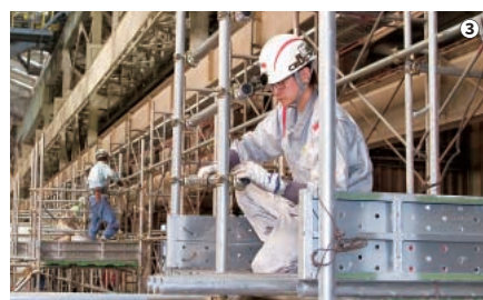
③ 足場架設 鋼管・直交クランプ・足場板・番線を使用时、安全で堅固な足場を架設する。
