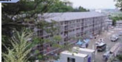
外壁工事開始(10月)
