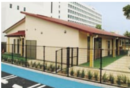
同社がパネル製造・建方を行い、太平工業が施工したアイシン精機(株)の託児所(愛知県刈谷市、2007年9月竣工)
