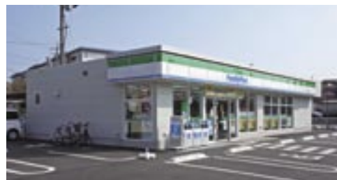
ファミリーマート(福岡県福岡市、2006年8月竣工)
