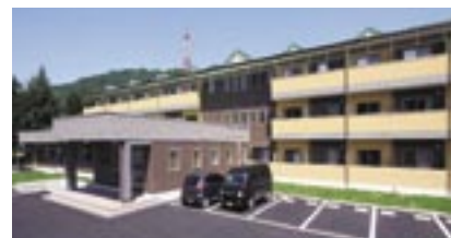
釜石製鉄所独身寮(岩手県釜石市、2007年7月竣工)
