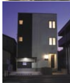
同社が建設した賃貸マンション (千葉県八千代市、2007年8月竣工)
